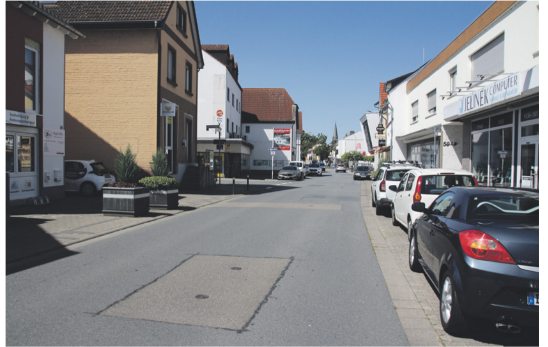
Bei der Neugestaltung der Darmstädter Straße wurde der dritte Bauabschnitt vor dem Medienschiff und der Heinrichstraße scheinbar vergessen.
